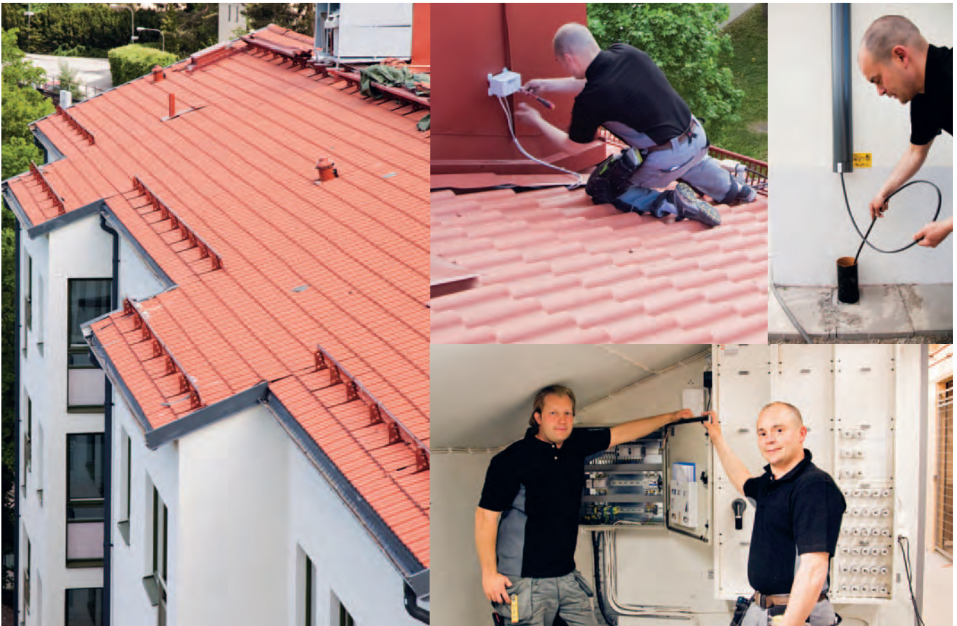
Här läggs takvärmekabel i ett kvarter i Stockholm – ett av många takprojekt med värmekabelsystem från Tyco Thermal Controls.
