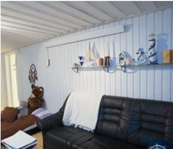
Thermoplus tar minimal plats, monterad i vinkeln mot taket.
